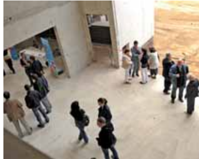
L'Ehpad en construction
