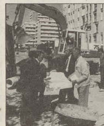
Visite du chantier.
