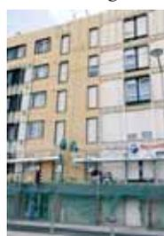
L'enveloppe des bâtiments est refaite entièrement avec des matériaux différents. Les menuiseries sont remplacées par du double vitrage et les façades sud sont dotées de protections solaires. 10 cm d'isolants sont ajoutés. Les nouvelles énergies sont utilisées
