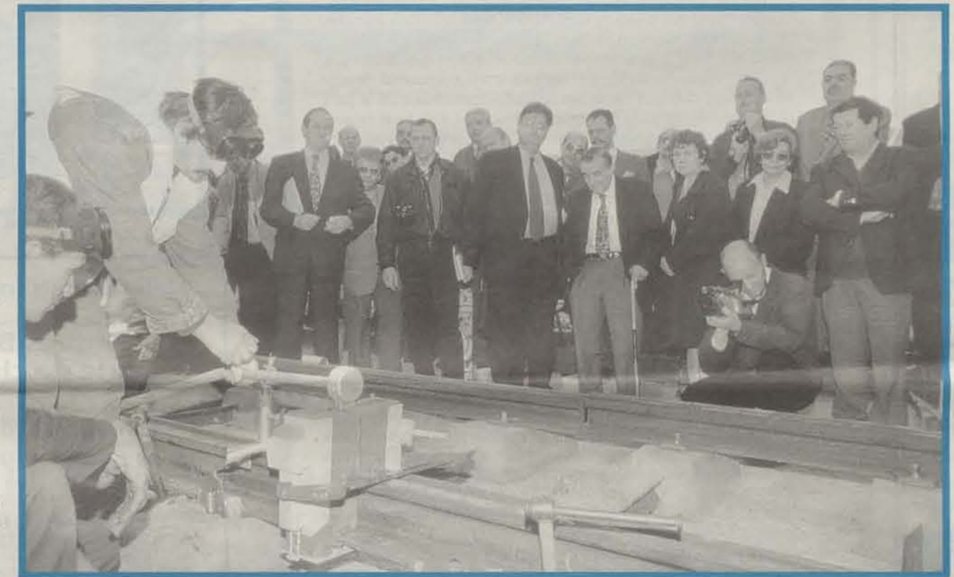
Pose du premier rail du tramway en avril 1998.
