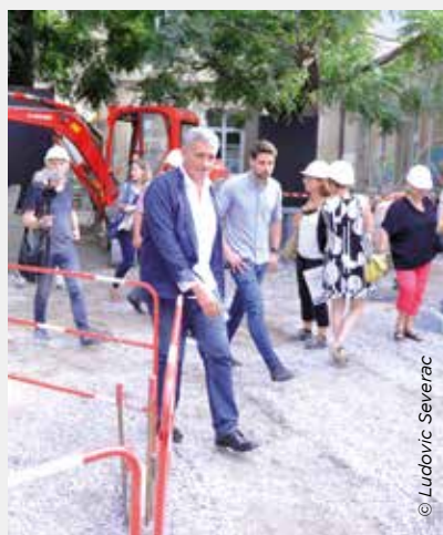
Le 18 août, Philippe Saurel a effectué une visite de chantier dans les écoles des quartiers Centre et Croix d'Argent.
