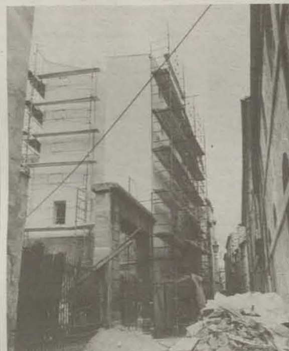
Réhabilitation Rue de la Monnaie
