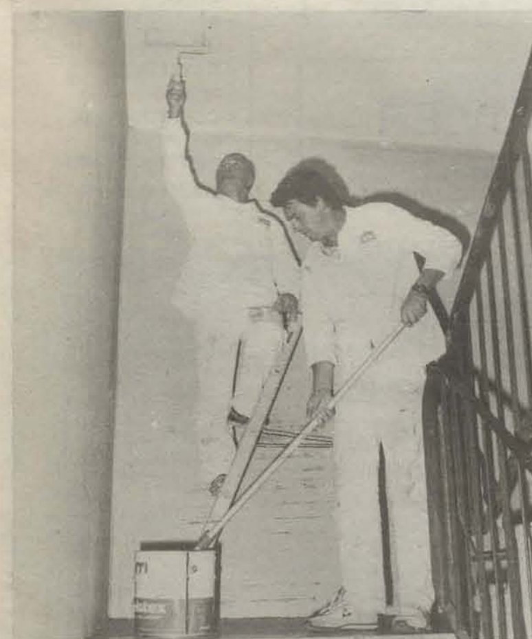
Travaux à la Paillade.
