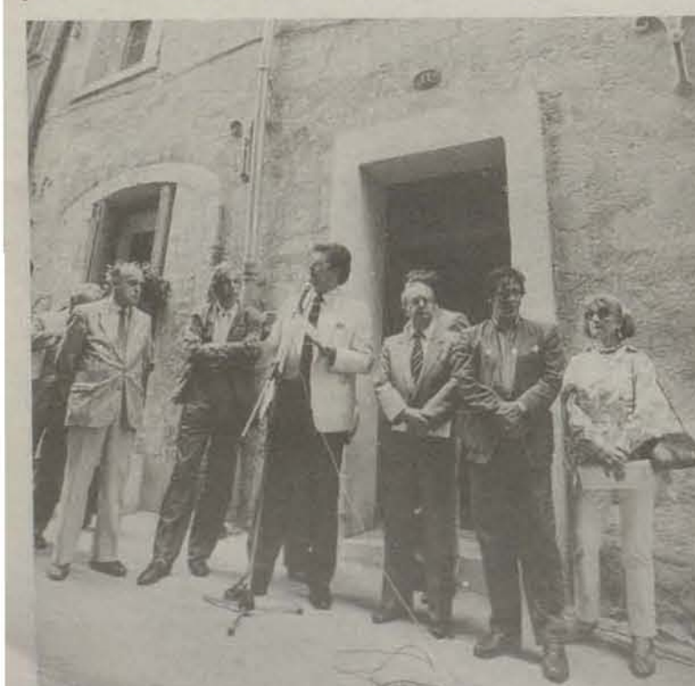
Réhabilitation d'immeubles Rue Verrerie Basse
