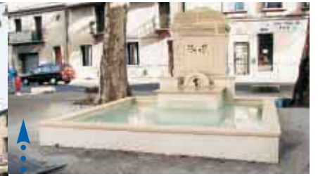
Inaugurés le 8 novembre dernier, les travaux de réhabilitation de la fontaine et de la place Renaudel ont été réalisés à la demande du Conseil de quartier Mosson qui a relayé les attentes du Comité de quartier Celleneuve. Aux travaux de réhabilitation proprement dits, s'ajoutent différents autres éléments qui concourent à l'aménagement paysager du vieux Celleneuve : installation de vases d'Anduze, renforcement du réseau d'éclairage, mise en lumière du clocher de l'église...
