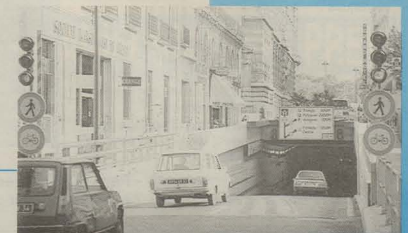
Création d'une troisième voie pour le tunnel de la Comédie.
