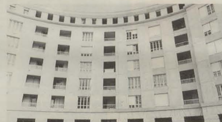
Résidence ATHENA - Ses nouveaux bureaux
