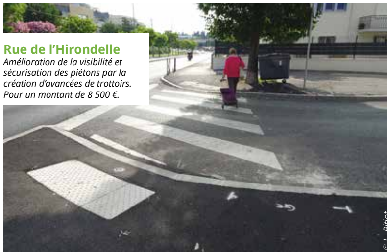
Rue de l'Aire Réfection des angles des trottoirs à tous les croisements, avec pose de bandes podotactiles. Investissement : 20 000 €.
