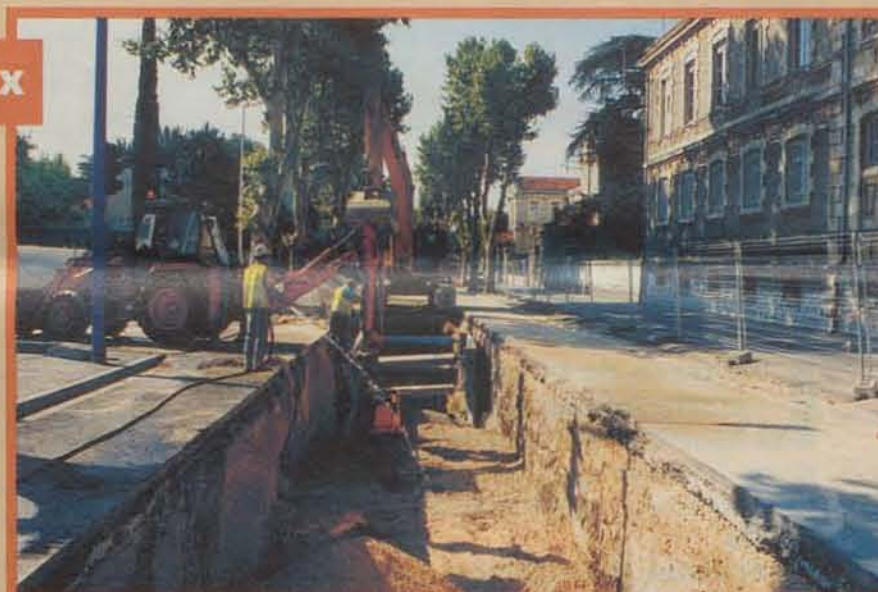
Les travaux de l'avenue du Professeur-Grasset avant la création de la plate-forme et la pose des rails.
