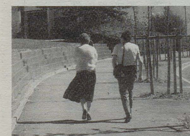
Réfection de trottoirs à la Paillade Avenue de Bologne.
