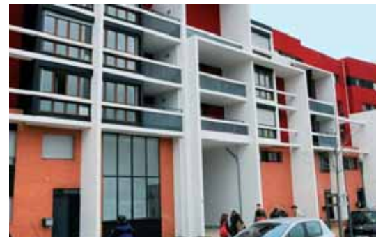
Des capteurs solaires assurent la production d'eau chaude.
