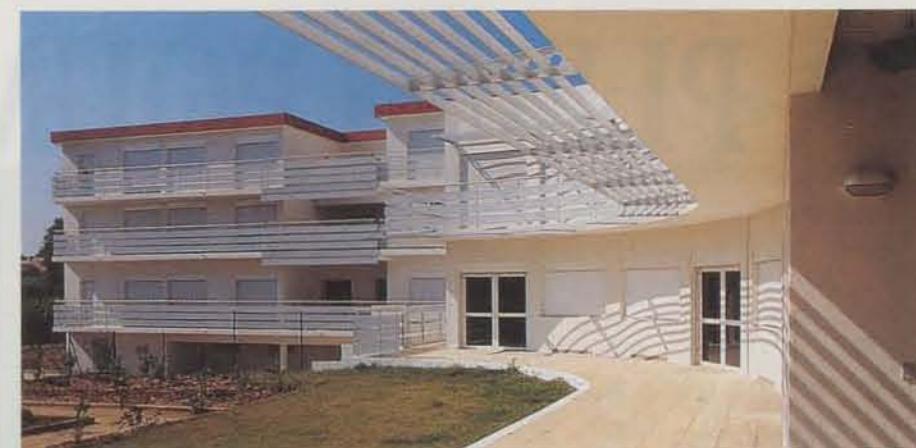
Une architecture lumineuse et fonctionnelle
