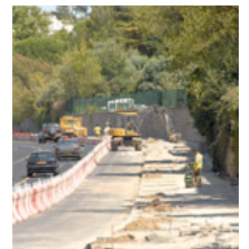
Des voies pour relier les quartiers.
