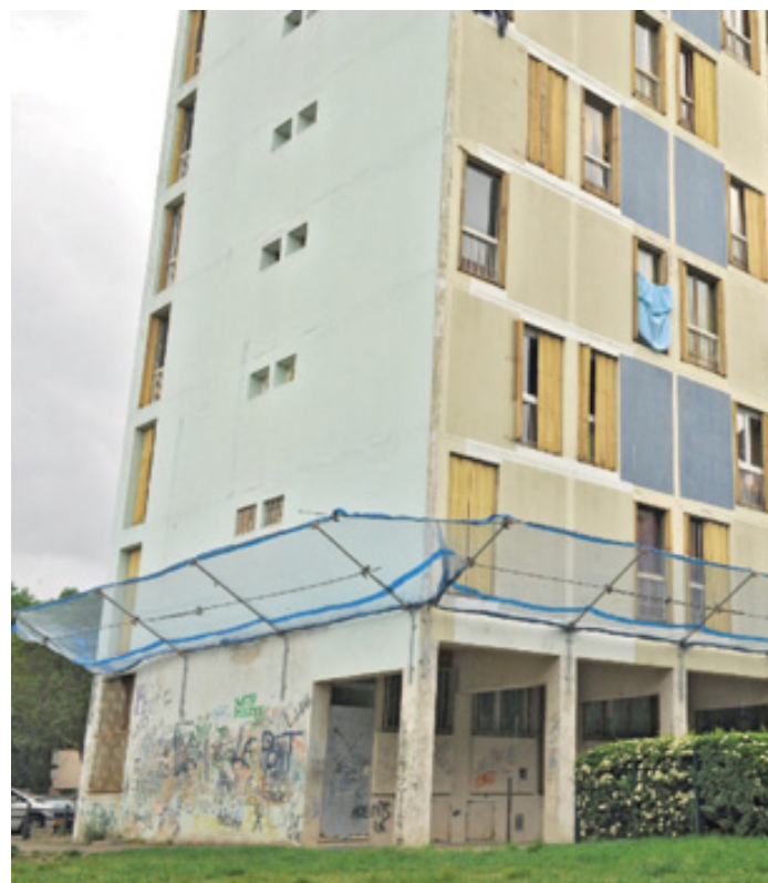
Un bâtiment en voie de réhabilitation.
