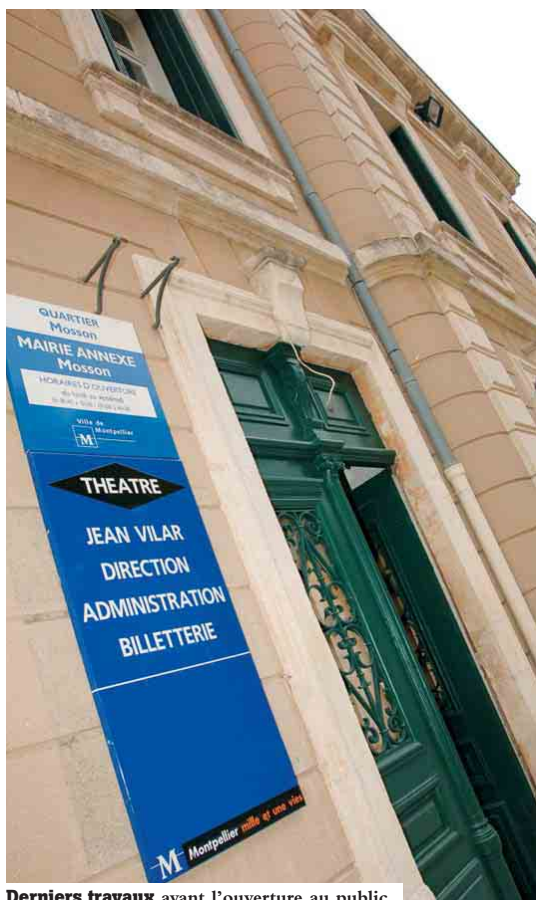
Derniers travaux avant l'ouverture au public.
