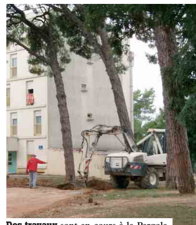
Des travaux sont en cours à la Pergola.
