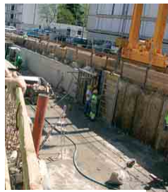
Conduite réalisée sous la plate-forme du tram, avenue Pédro-de-Luna.
