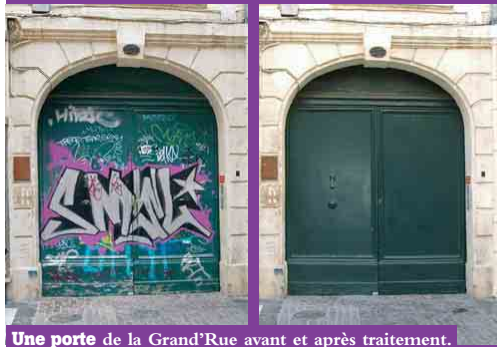
Une porte de la Grand'Rue avant et après traitement.
