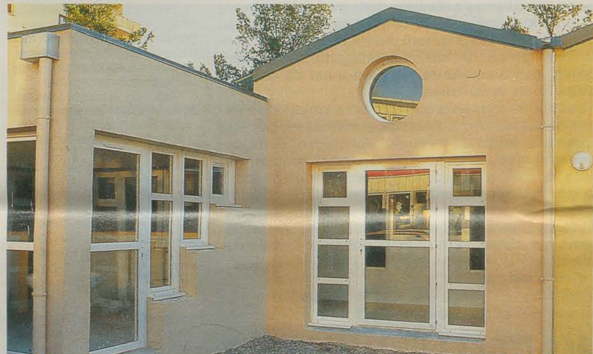
L'école maternelle de Lantissargues constitue la première tranche des travaux de réhabilitation de ce groupe scolaire. Une réussite architecturale pour une rentrée en douceur des tout petits.
