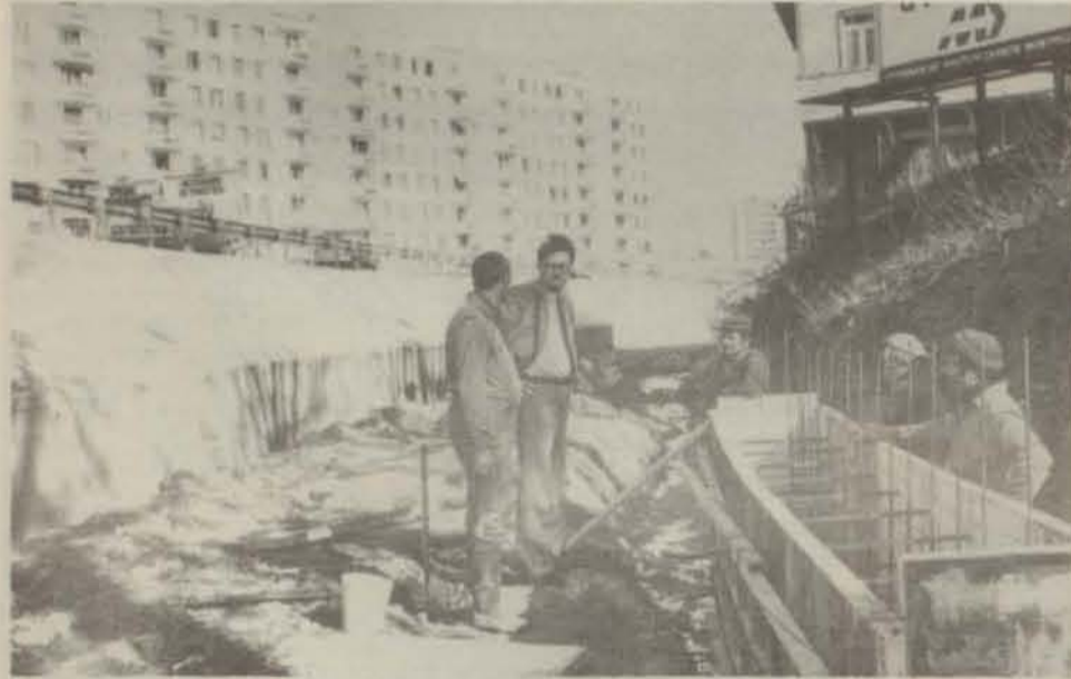
La canalisation du Verdanson pour éviter les dégâts des eaux se poursuit le long du quartier des Aubes. Dès la fin des travaux, le jeu de boules sera remis en état.
