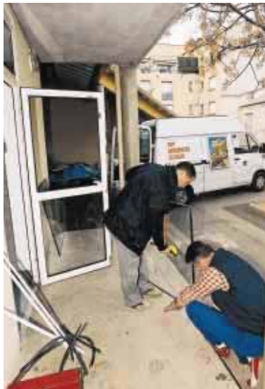
Remplacement d'une baie vitrée à l'école élémentaire Sévoigné.
