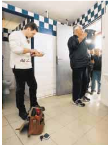
Changement d'interrupteur et vérification de la ligne électrique à l'école élémentaire Joseph-Delteil.
