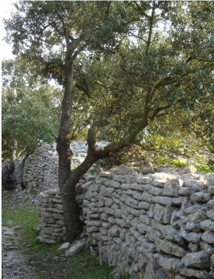
Mur en pierre sèche
