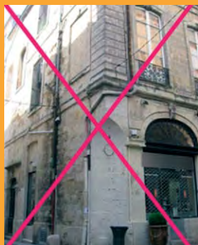
Mauvaise insertion des descentes d'eaux pluviales
