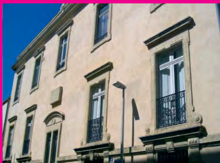
Façade avec enduit de chaux et éléments de pierre de taille : rue Duval Jouve
