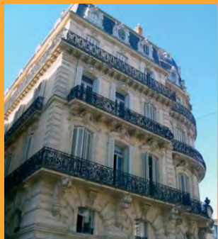
Immeuble ravalé dans les règles de l'art
