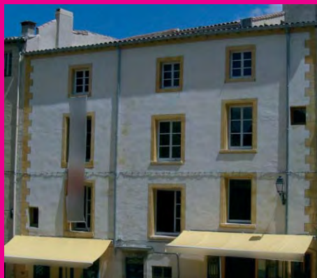
Façade avec enduit et décors peints (encadrements et chaînes d'angle) : rue Saint Pierre
