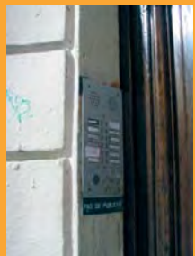
Porte d'entrée avec boîtier simple posé en tableau préservant le décor de la façade
