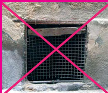
Sopirail remplacé par un grillage
