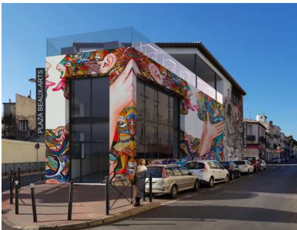
Un bâtiment de 800 m 2
