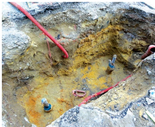
MICROPIEU EN COURS DE MISE EN ŒUVRE
