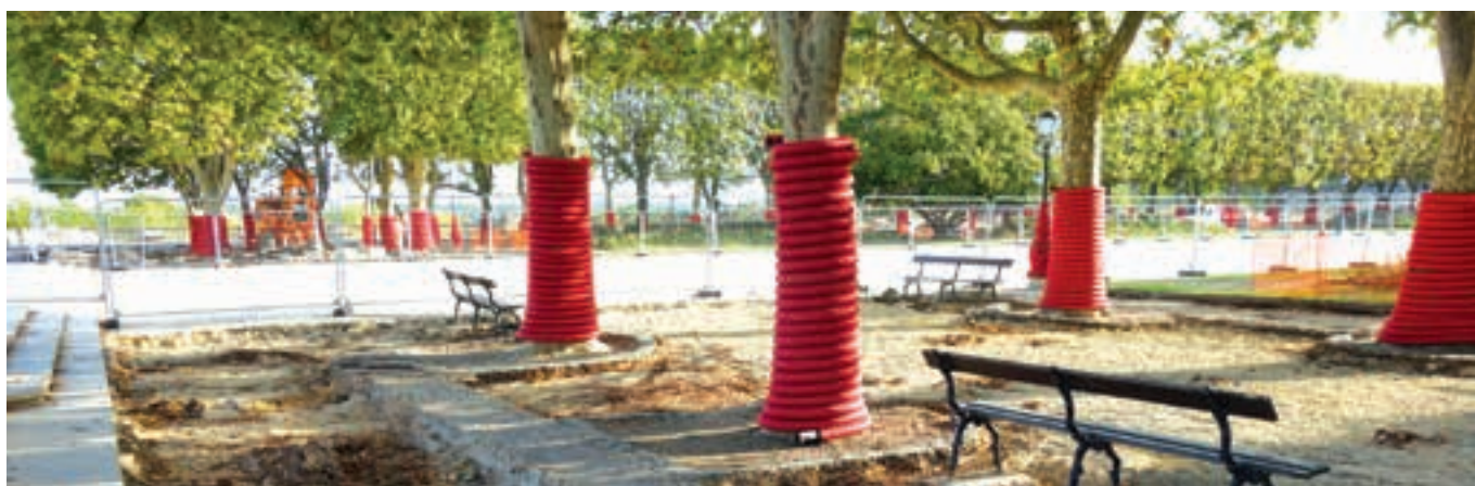
TRAVAUX DE RÉFECTION DES REVÊTEMENTS À PROXIMITÉ DES PLATANES, PROMENADE DU PEYROU (SOURCE : POUSSE CONSEIL)
