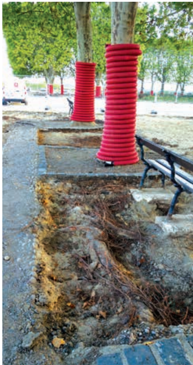
TRAVAUX DE RÉFECTION DES REVÊTEMENTS À PROXIMITÉ DES PLATANES, PROMENADE DU PEYROU (SOURCE : POUSSE CONSEIL)
