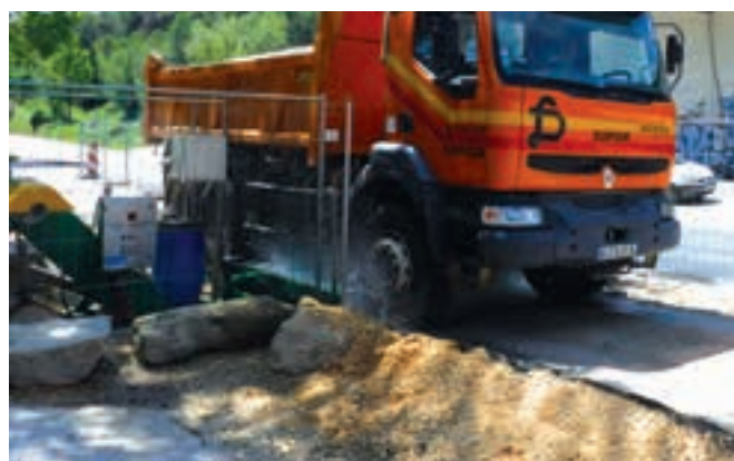
PÉDILUVE MOBILE EN ENTRÉE DE CHANTIER
