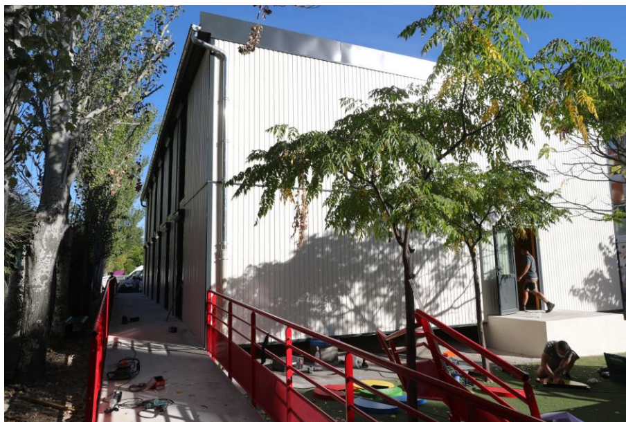
Nouvelles salles en modulaire pour le dédoublement des classes CP/CE1, école Julie Daubié (quartier Cévennes) - Ville de Montpellier
