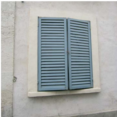
Le volet persienné dissimule un climatiseur.
