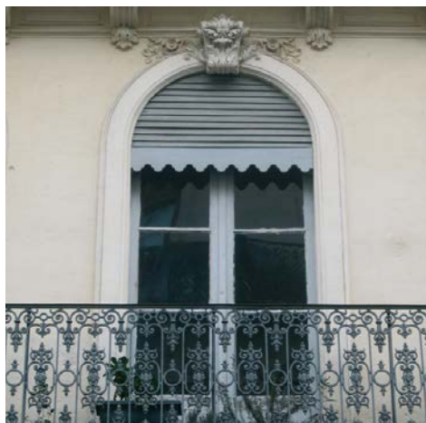
Le lambrequin, en partie haute de la fenêtre, est rainuré.
