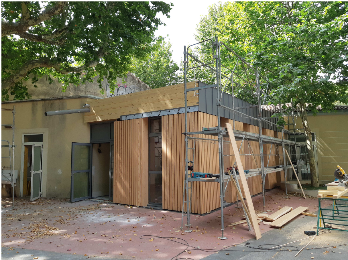
Le chantier d'extension dans la cour de l'école – Ville de Montpellier
