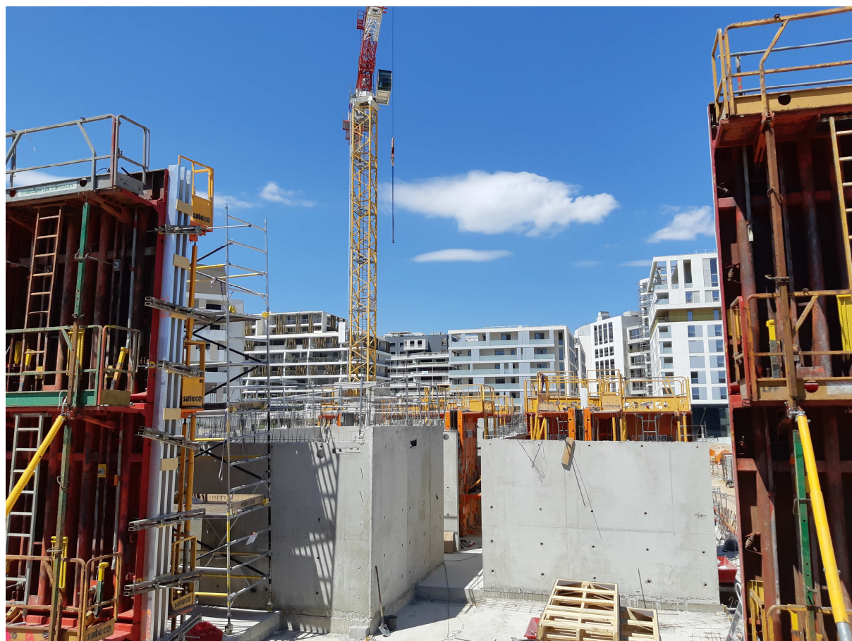
Le chantier de construction de l'école primaire Joan Miró – Ville de Montpellier
