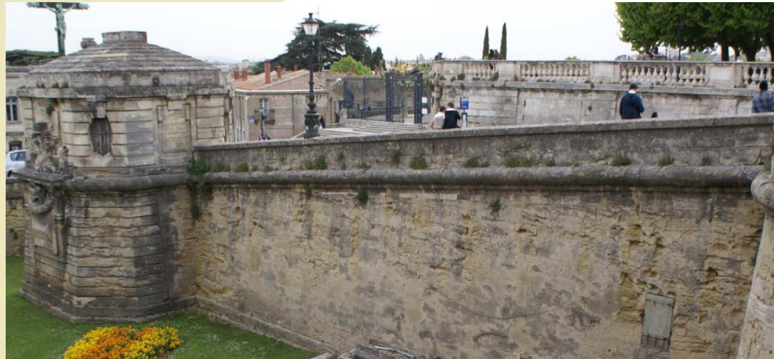
Restauration des parements.
