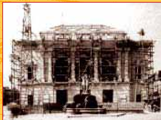
Construction du théâtre - plaque sur verre - 1887 coll. particulière
