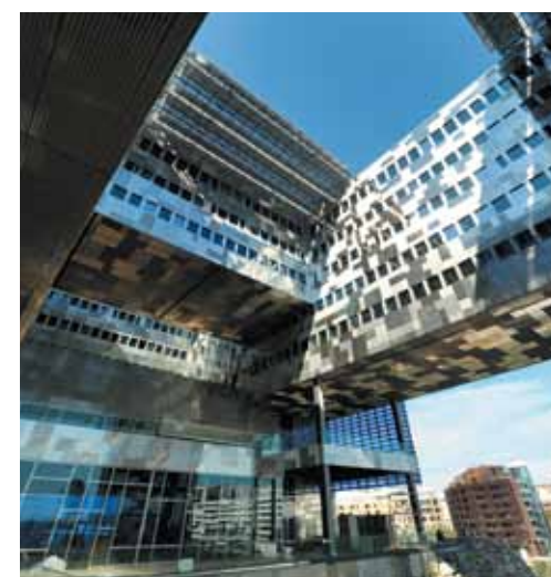
Vue d'une des cours intérieures.
