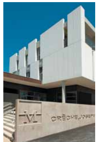
La crèche Joséphine-Baker, en construction à Ovalie, qui ouvrira en mai.
