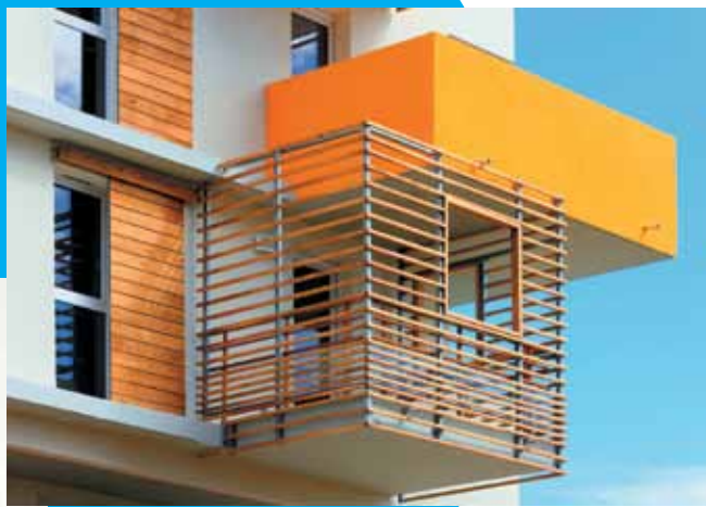
Détail d'un immeuble de Parc Marianne, dont le quartier prend forme le long de l'avenue Raymond-Dugrand.
