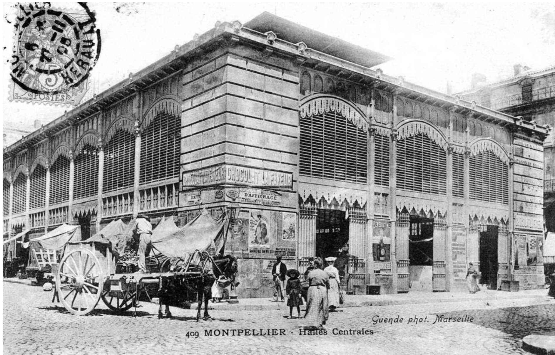
Halles centrales, carte postale, autour de 1900. Archives municipales de Montpellier, 6Fi26
