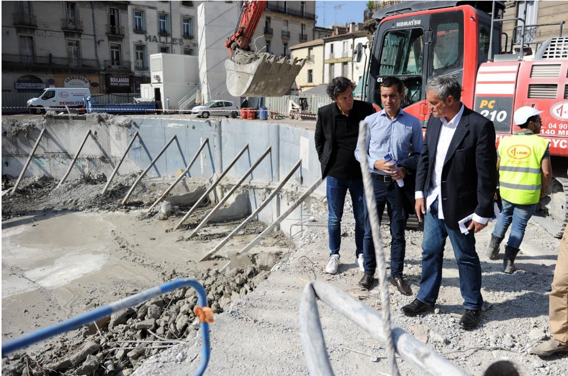
Philippe Saurel sur le chantier sur l'emplacement de la future et nouvelle halle Laissac en 2018. Ville de Montpellier
