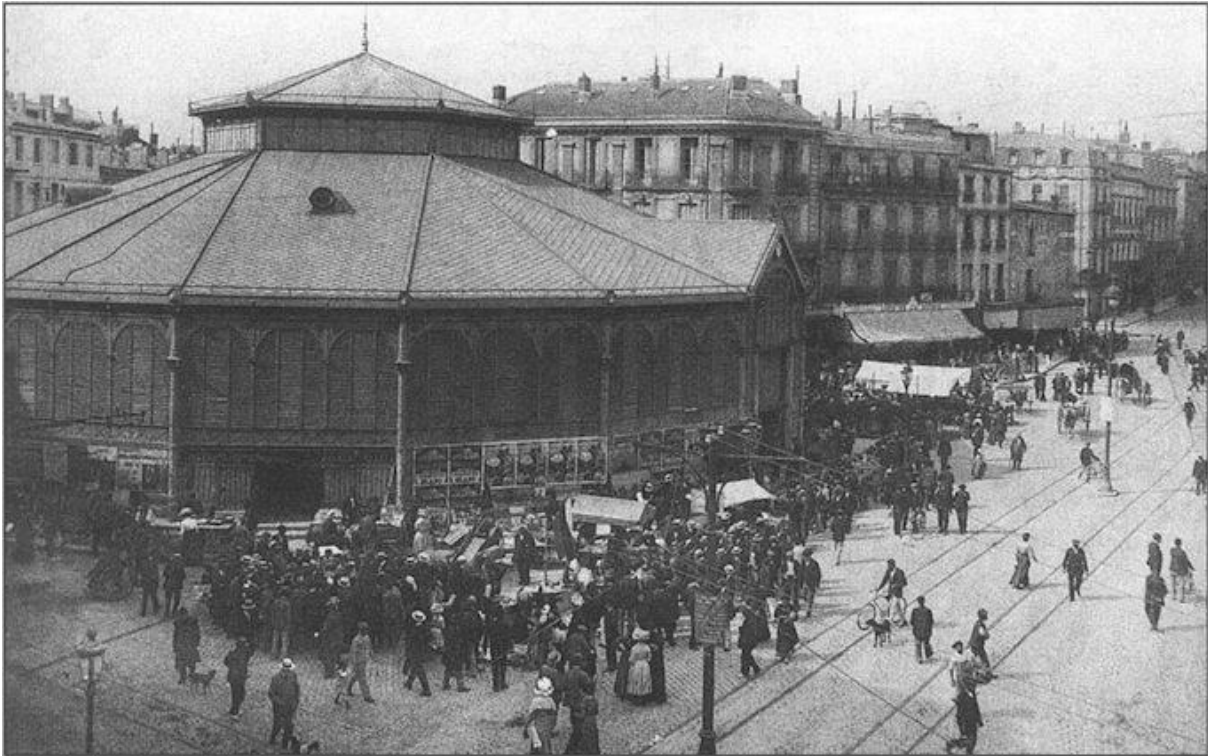
Au XIX e siècle, le marché couvert sous forme de halle polygonale type Baltard implanté au cœur de la place de l'Observatoire, architectes : Lazard et Alaus. Crédit : DR.
