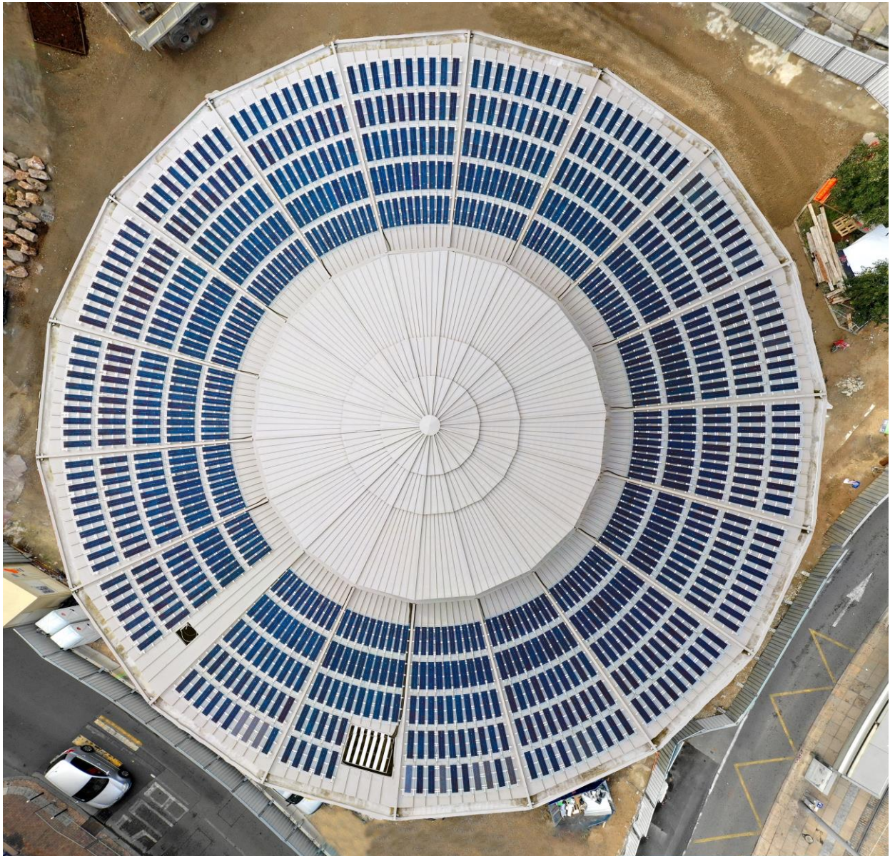
La toiture des halles Laissac recouverte des modules photovoltaïques vue depuis un drone. Crédit : Sébastien MEXMAIN, SARL Visadrone.
