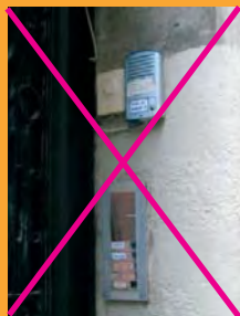
Porte d'entrée avec multiples boîtiers
