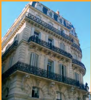
Immeuble ravalé dans les règles de l'art
