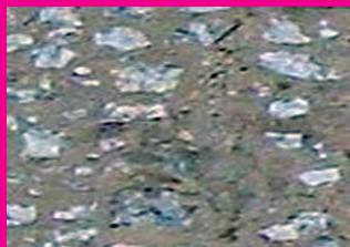
Maçonnerie de moellons
