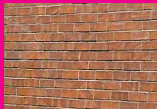
Maçonnerie de briques
