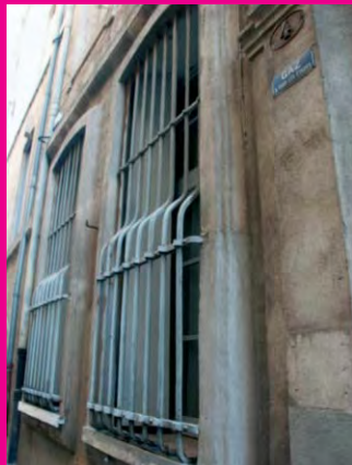
Grille de protection d'origine en fer plein
