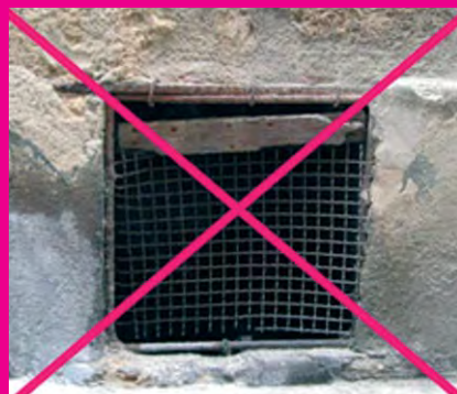
Sopirail remplacé par un grillage
