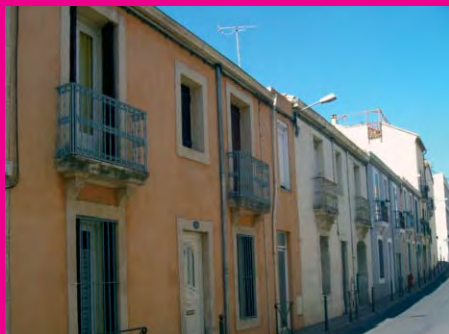
Séquence de façades enduites tenant compte de l'unité urbaine : rue Louis Braille
