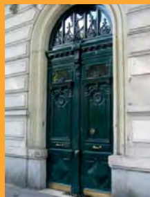
Porte d'entrée avec plaques de protection de bas de porte en laiton
