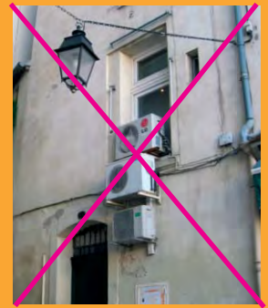
Pose d'appareils de climatisation en saillie sur la façade
