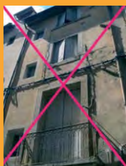
Multiplés câblages noirs posés au centre de la façade
