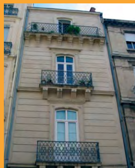
Bonne insertion des différents réseaux : câbles, boîtiers électriques, descentes d'eaux pluviales
